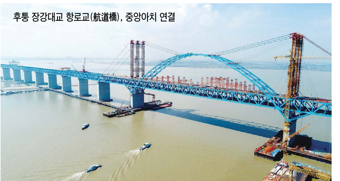
후통 장강대교 항로교(航道橋), 중앙아치 연결 10월 22일, 세계 최대 도로·철도 겸용 강철 아치교인 후통(상하이-난통)장강대교 중앙 아치가 성공적으로 연결되었는데 이는 후통대교의 전 구간 개통에 한 발짝 더 가까워졌음을 의미한다. 후통대교는 2019년에 완공될 예정인바 그 때가 되면 난통에서 상하이까지 가장 짧은 시간이면 도착할 수 있다. 또한 산둥성 동부, 장쑤 북부와 남부, 상하이, 저장성 동부 지역 간의 가장 편리한 철도수송 통로가 될 예정이며, 연해지역 경제발전에 활력을 불어넣게 된다. 사진은 연결된 텐생항(天生港) 항로교이다.
